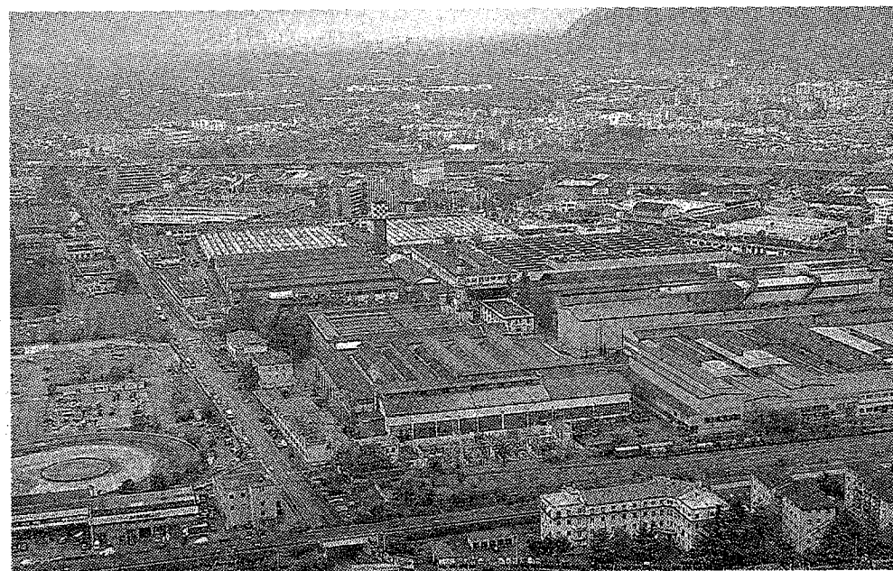
Bolzano Sud L'amianto veniva utilizzato per la sua resistenza alle alte temperature
